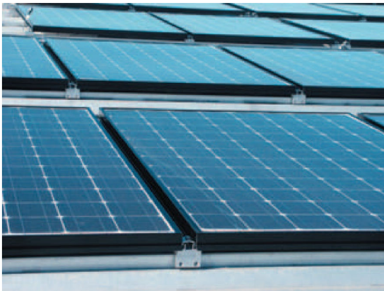
Figure 3.2.2-1. Panneaux solaires fixés à une toiture à joint debout au moyen de brides de fixation de joint extérieur
