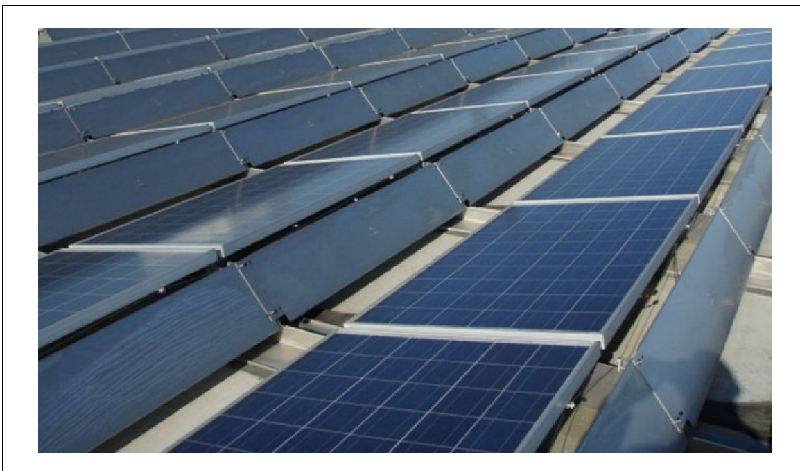
Figure 2.1.1.1-1. Déflecteurs d'air installés sur le côté haut des panneaux de chaque rangée (groupe compact)
