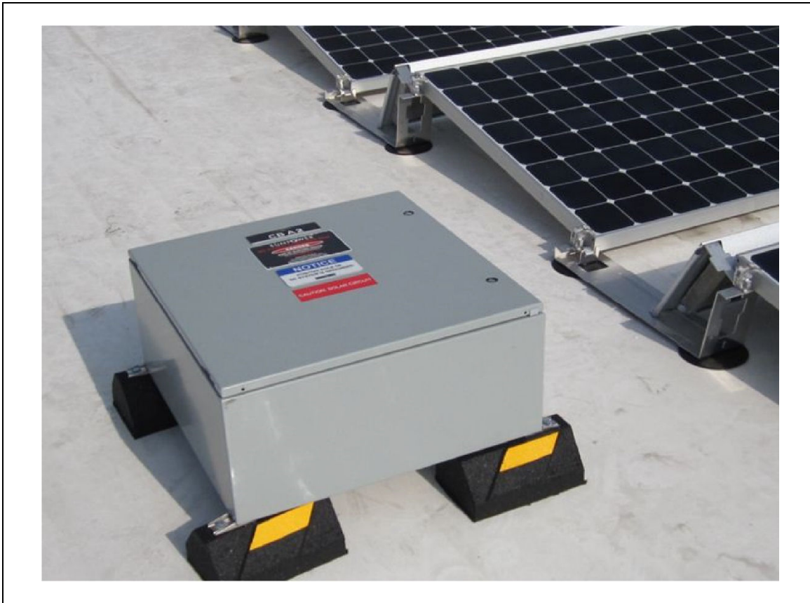
Figure 3.2.1.1-3. Équipement non fixé à la structure du toit
