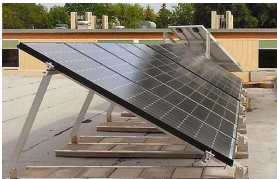
Figure 3.2.1.1-2. Panneaux solaires à forte pente ou dépourvus de déflecteurs d'air subissant plus fortement les effets du vent
