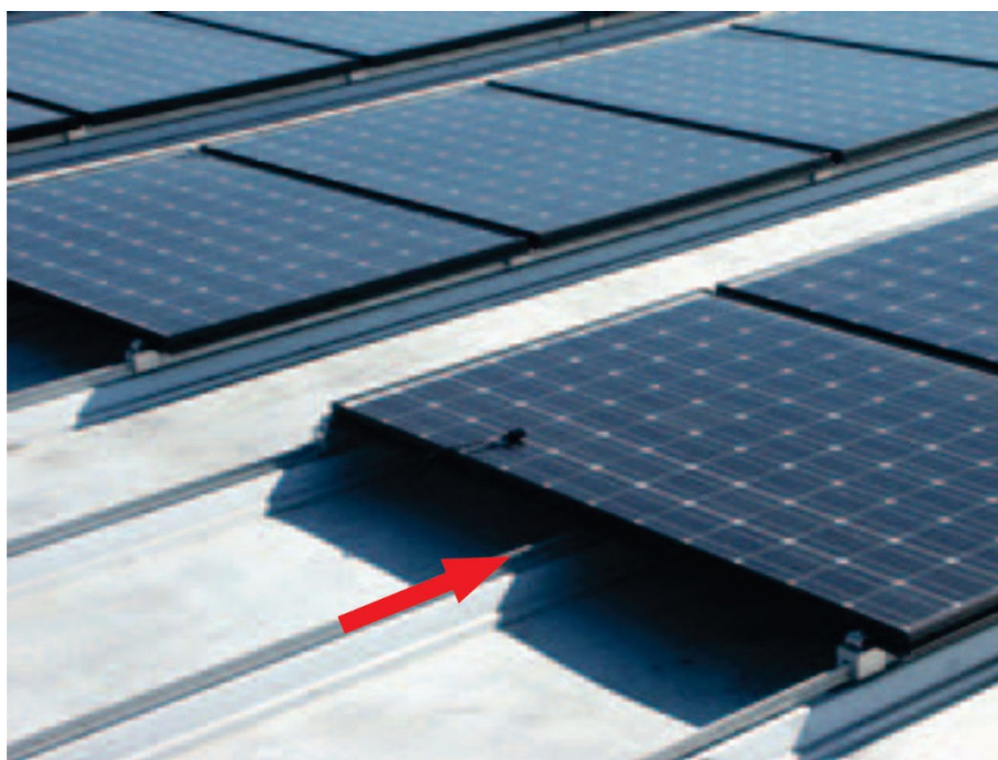
Figure 3.2.2-2. Configuration non acceptable sauf essais spécifiques et obtention de l'agrément FM : bride de fixation absente de la nervure sous le milieu du bord d'un panneau extérieur
