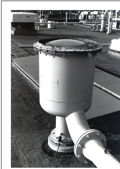
Fig. E.2.2-1. Explosion diverter
