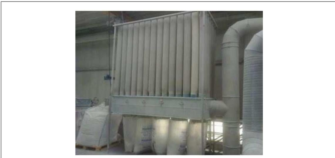
Fig. 11. Exemplo de coletor sem invólucro
