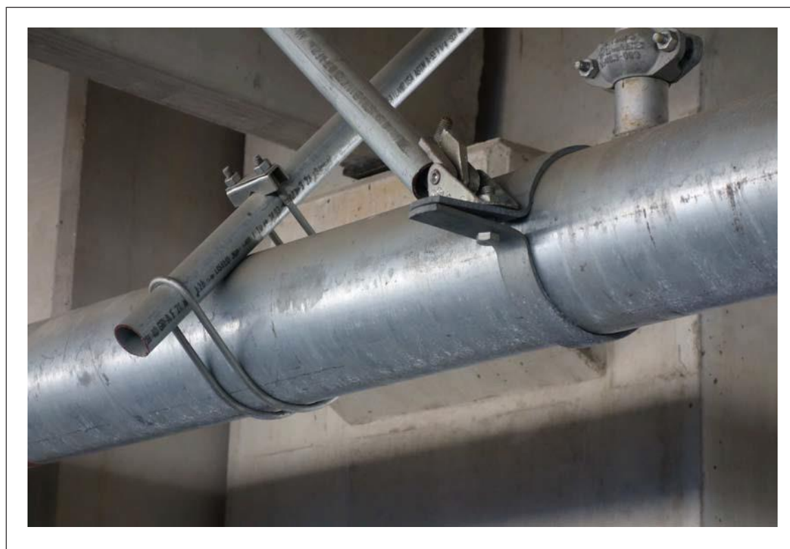
Figura 3.1.1-B. Ejemplos de componentes fijados a tuberías (deben estar homologados por FM)
